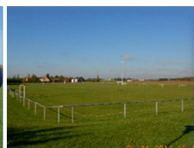
La municipalité protège son terrain : Pose d'une main-courante
